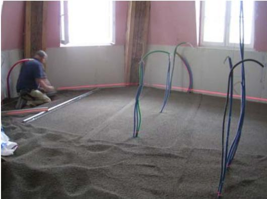
La présence de nombreuses variations altimétriques des planchers, allée à la contrainte de limitation des surcharges applicables à la structure existante, (qui ne pouvait être renforcée dans la hauteur des rez-de-chaussée du fait de la présence de commerces en activités) nous ont conduit à proposer la mise en œuvre de « chapes sèches » sur les solives conservées.
