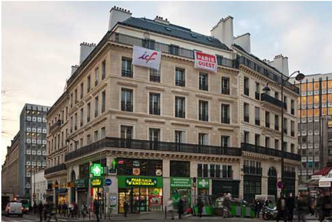
Opération d'envergure pour 3 immeubles haussmannien à Paris ...
